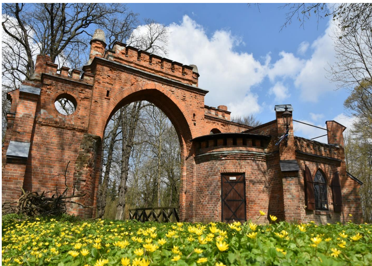
Fot.12. Brama z domkiem odźwiernego w Kryłowie
